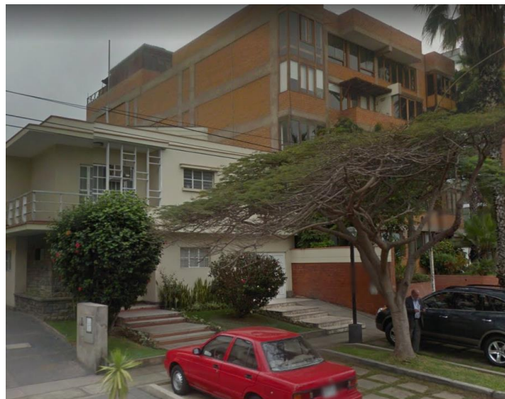
Imagen 01.- Vista Principal del Predio, lindero derecho.
